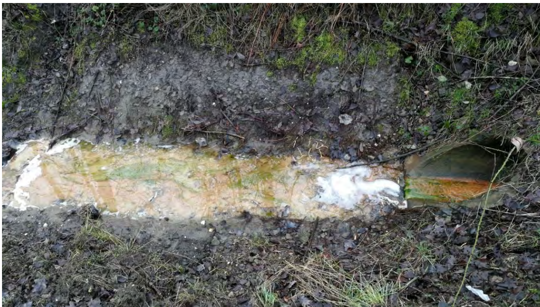
Abbildung 51: Randgraben an der Eichenallee mit Eisenoxid-/hydroxidausfällungen, Schaumbildung sowie starkem Algen(?)wachstum. (Datum der Aufnahme: 23. Januar 2020). 87
