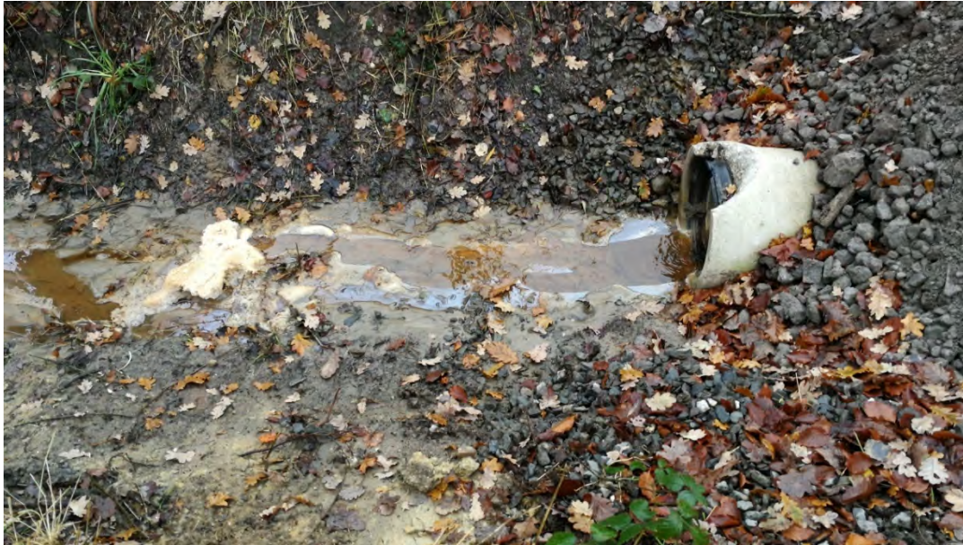
Abbildung 50: Randgraben am Mühlenbergweg mit Eisenoxid-/hydroxidausfällungen, Schaumbildung und schlierenartigem Bakterienfilm. (Datum der Aufnahme: 20. November 2019). 86
