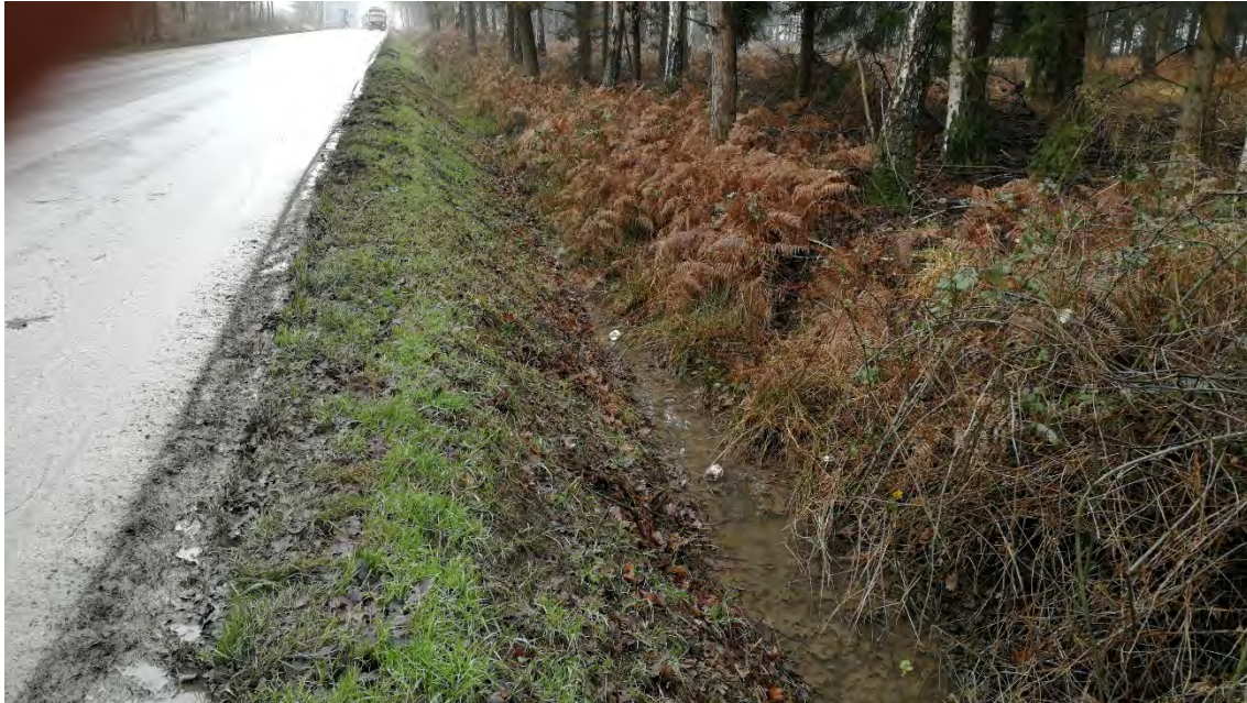
Abbildung 53: Entwässerungsgraben an der Westseite der Eichenallee (Datum der Aufnahme: 23. Januar 2020). 90
