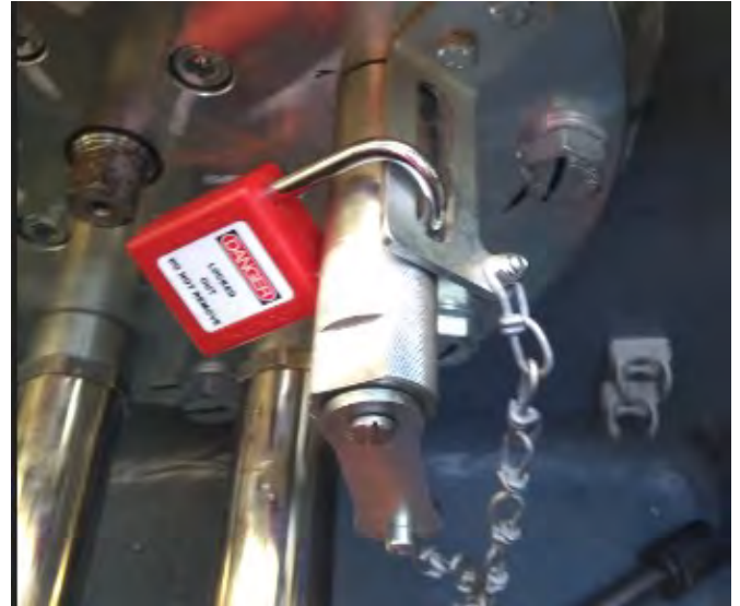
Abb. 17: Sichern der Rotorsperre an der langsamen Welle – 3MW
