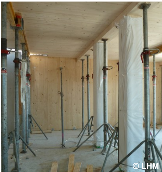
Sichtbare Unterzüge und Holzstützen
